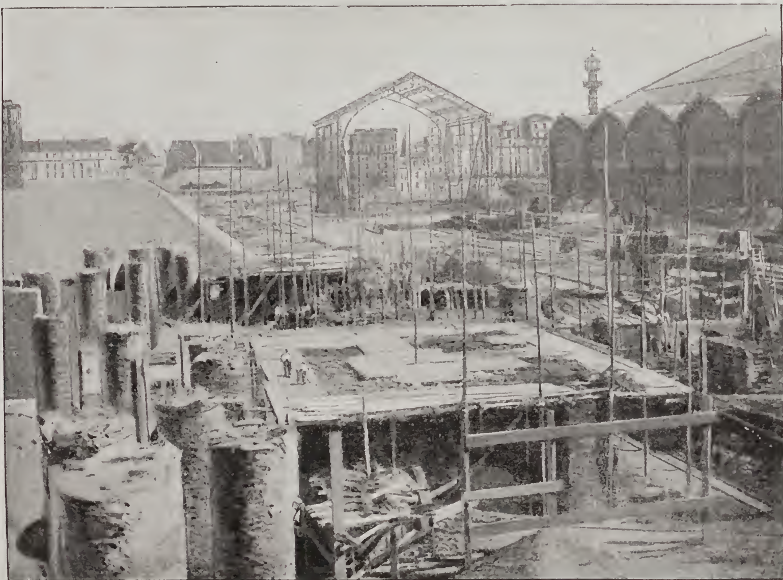
LE CHATEAU D'EAU MONUMENTAL. — Etat d'avancement des travaux dans les premiers jours d'avril.
